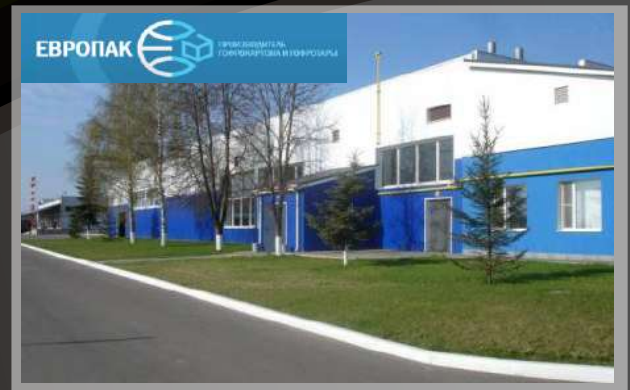
Поставка оборудования с монтажными и пусконаладочными работами
