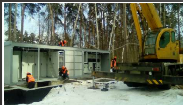
Поставка оборудования с монтажными и пусконаладочными работами
