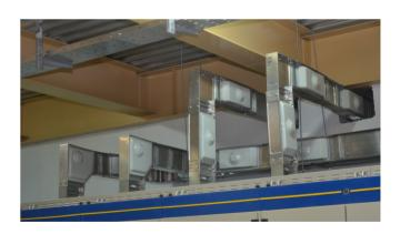
Вводная панель ГРЩ "Оскол" с подводом шинопровода сверху и отводом кабелей снизу
